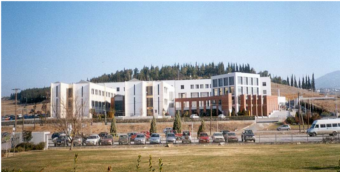
Εικόνα 1: Εγκαταστάσεις Εθνικού Κέντρου Έρευνας και Τεχνολογικής Ανάπτυξης. (Το μεσαίο κτίριο στεγάζει το Ελληνικό Ινστιτούτο Μεταφορών).
